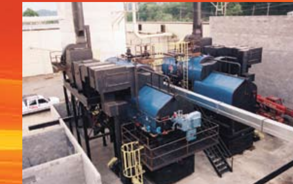
600 BHP doble Planta de enchapado de madera dura Aplicación de calor de secado para tanques de vapor y secador de "serpentin".
