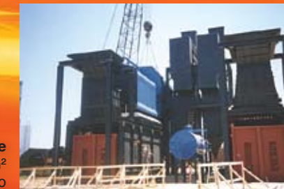
1200 BHP doble 450 LB/PULG 2 sobrecalentado
